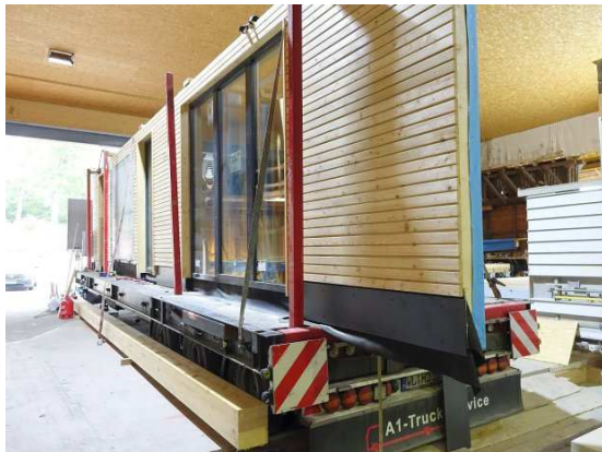
Das knapp 13 Meter lange Wandelement wird samt Fenstern transportiert
